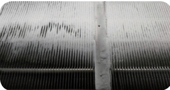
普通柜体： 标准工况下冰霜附着于蒸发器， 阻断了气流，需要定时融霜
